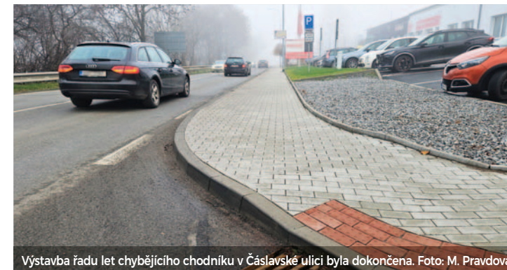
Výstavba řadu let chybějícího chodníku v Čáslavské ulici byla dokončena. Foto: M. Pravdová
