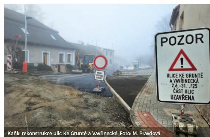
Kaňk: rekonstrukce ulic Ke Gruntě a Vavřínecké. Foto: M. Pravdová
