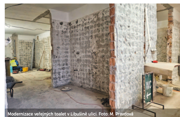
Modernizace veřejných toalet v Libušině ulici. Foto: M. Pravdová
