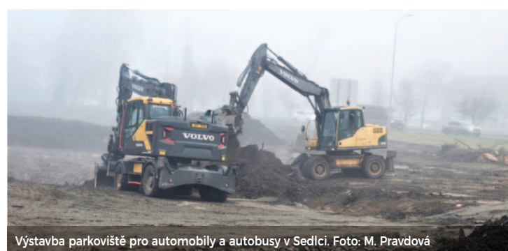
Výstavba parkoviště pro automobily a autobusy v Sedlci. Foto: M. Pravdová
