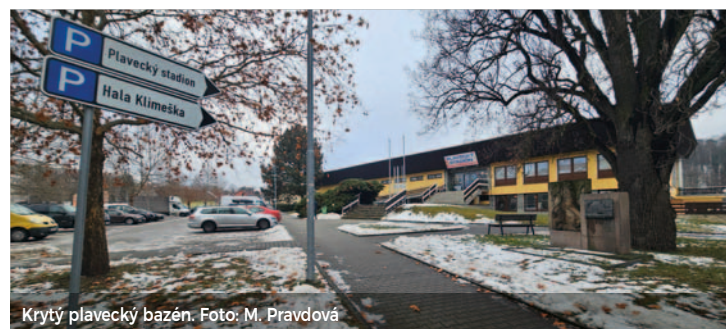
Krytý plavecký bazén. Foto: M. Pravdová
