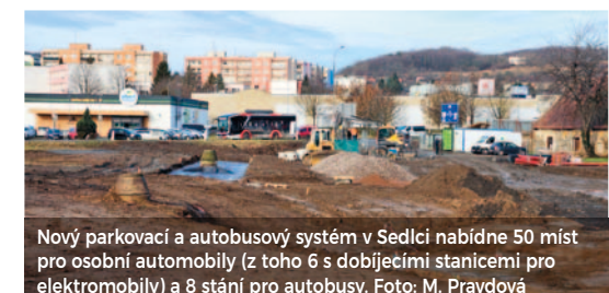
Městu se na výstavbu parkoviště podařilo získat dotaci ve výši téměř 38 milionů korun. Snímek je z poloviny února, kdy pokračovala pokládka kanalizace. Foto: M. Pravdová
