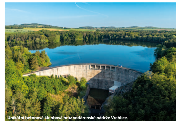
Unikátní betonová klenbová hráz vodárenské nádrže Vrchlice.
