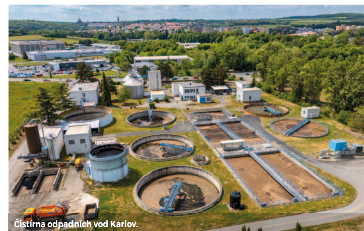
Čistírna odpadních vod Karlov.
