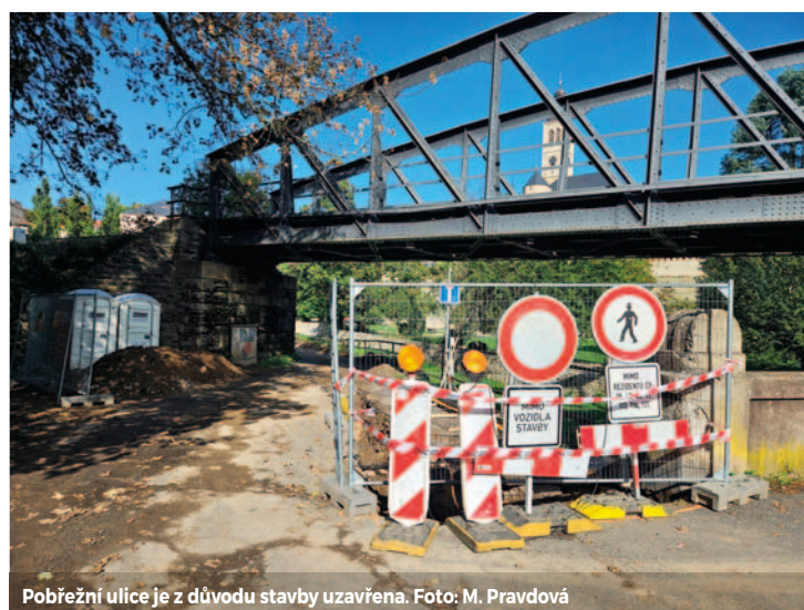
Pobřežní ulice je z důvodu stavby uzavřena. Foto: M. Pravdová
