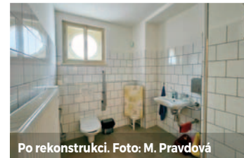
Po rekonstrukci. Foto: M. Pravdová
