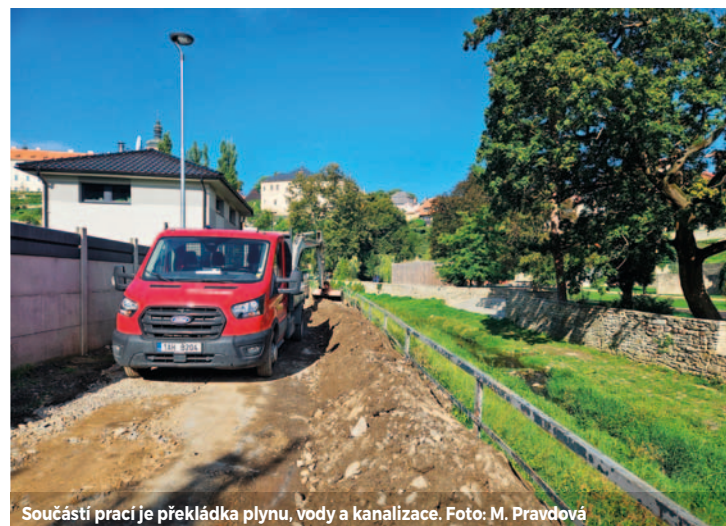
Součástí prací je překládka plynu, vody a kanalizace. Foto: M. Pravdová
