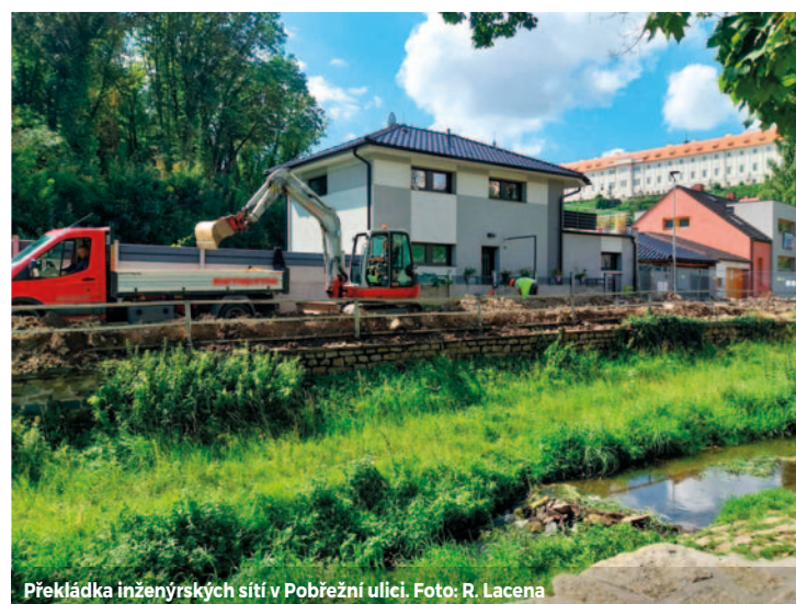
Překládka inženýrských sítí v Pobřežní ulici. Foto: R. Lacena
